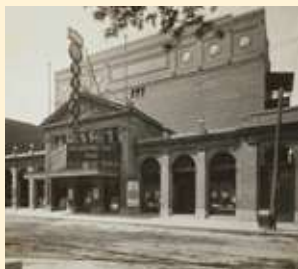
Vue de la façade du théâtre vers 1930. Photo : Archives du Théâtre St-Denis.
