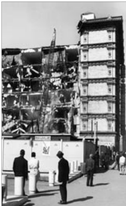
ILL. 16. DÉMOLITION DE L'ÉDIFICE WOODHOUSE DEPARTMENT STORE, 1965.
