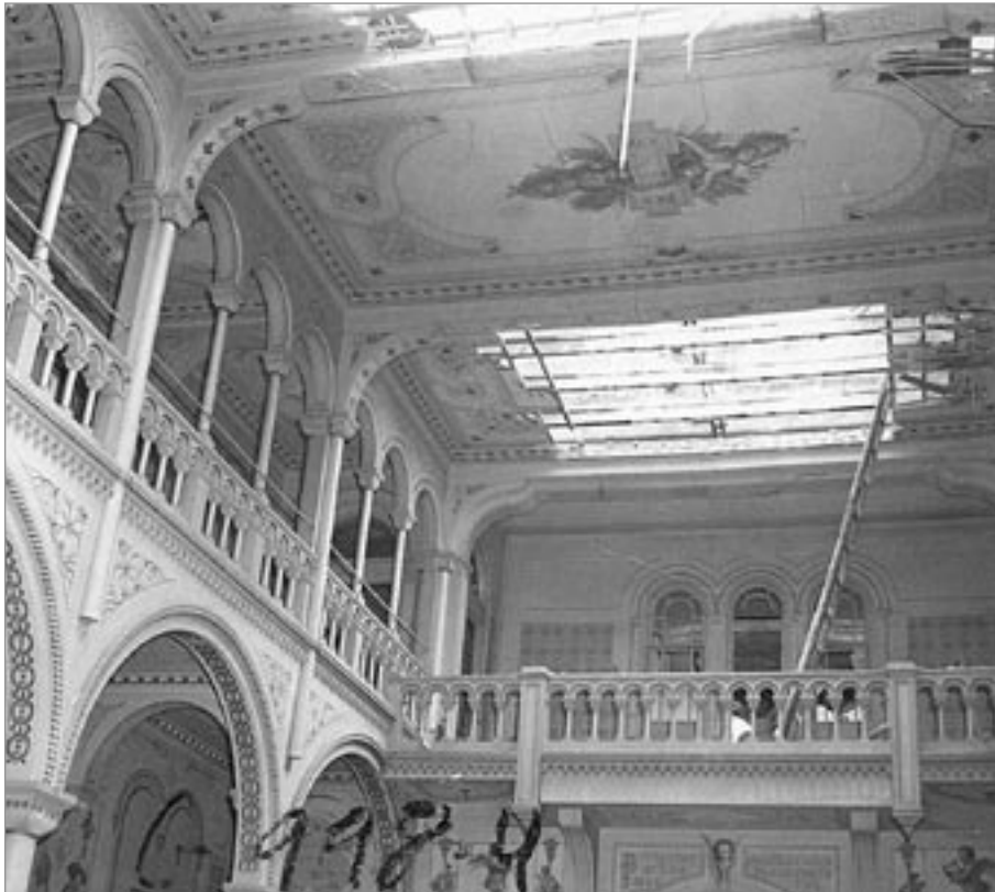
ILL. 19. INTÉRIEUR DE L'ORATOIRE SAINTE-THÉRÈSE DE L'ENFANT-JÉSUS AVANT SA DÉMOLITION, V. 1958-1959.
