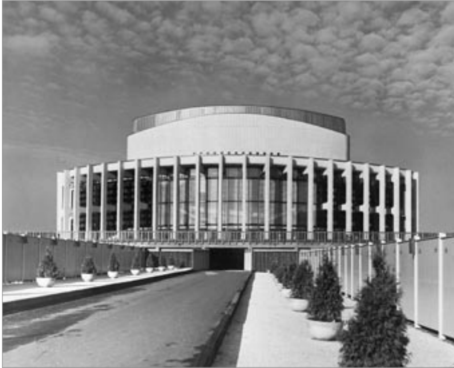
ILL. 41. ALLÉE MENANT À L'ENTRÉE DE LA GRANDE SALLE DE LA PLACE DES ARTS, AMÉNAGÉE AINSI DE 1963 À 1967, AFFLECK, DESBARATS, DIMAKOPOULOS, LEBENSOLD, MICHAUD & SISE ARCHITECTES.
