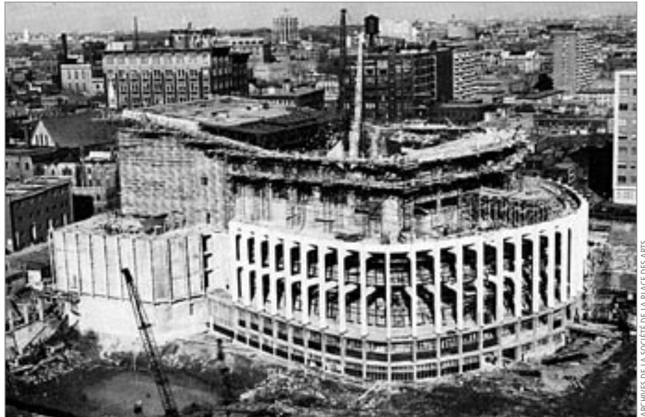
ILL. 23. LA GRANDE SALLE EN CONSTRUCTION, V. 1962.
