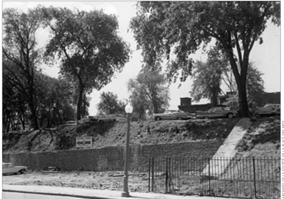
ILL. 13. DÉNIVELLATION DU SITE DE LA FUTURE PLACE DES ARTS, V. 1958-1959.
