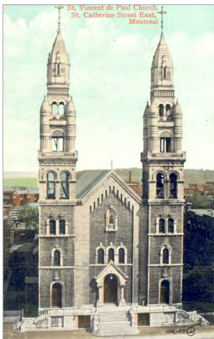
ILL. 24. MONTRÉAL. ÉGLISE SAINT-VINCENT-DE-PAUL. ADOLPHE LÉVÊQUE, ARCHITECTE, 1875. | BANQ, QUÉBEC, P547,S1,SS1,SS51,D2, P4303.
