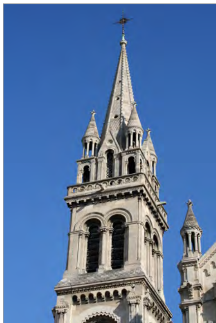
ILL. 38. PARIS. ÉGLISE SAINT-AMBROISE. UN DES DEUX CLOCHERS. THÉODORE BALLU ARCHITECTE, 1863-1869. | LUC NOPPEN, 2015.
